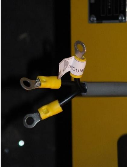
Обратите внимание, питающий кабель осветительной мачты оконцован клеммами. Вы должны самостоятельно выбрать способ подключения в зависимости от используемого источника питания.
